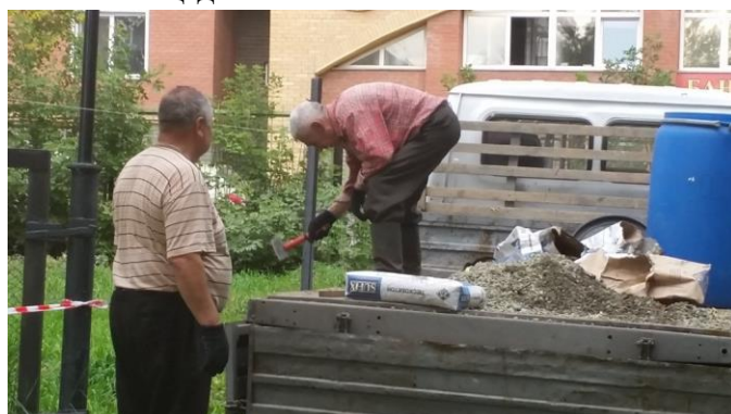
Установка и бетонирование столбиков
