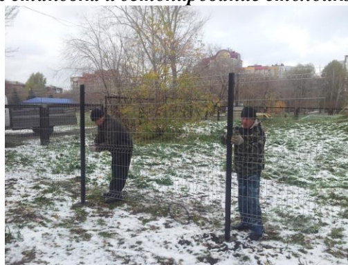
Монтаж оцинкованных панелей для ограждения вольера для копытных
