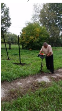
Подготовка лунок для столбиков ограждения
