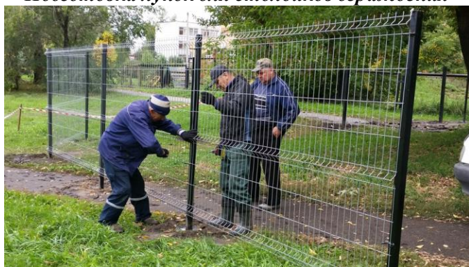
Монтаж оцинкованных панелей для ограждения вольера для копытных
